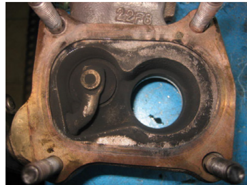
Junta montada correctamente
