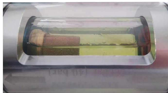
Presenza di umidità
