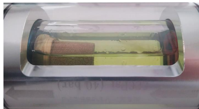
Presencia de humedad
