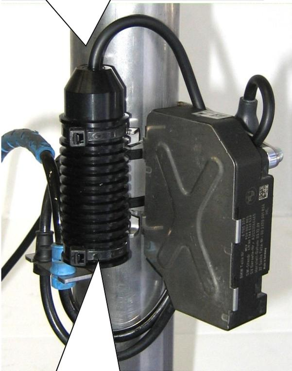
Stilllegung an der Edelstahlhalterung mit Kabelbinder 4,8mm x 290mm befestigen. Zusätzlich muss die Steckverbindung mit einem Kabelbinder am Originalsteuergerät befestigt werden.
