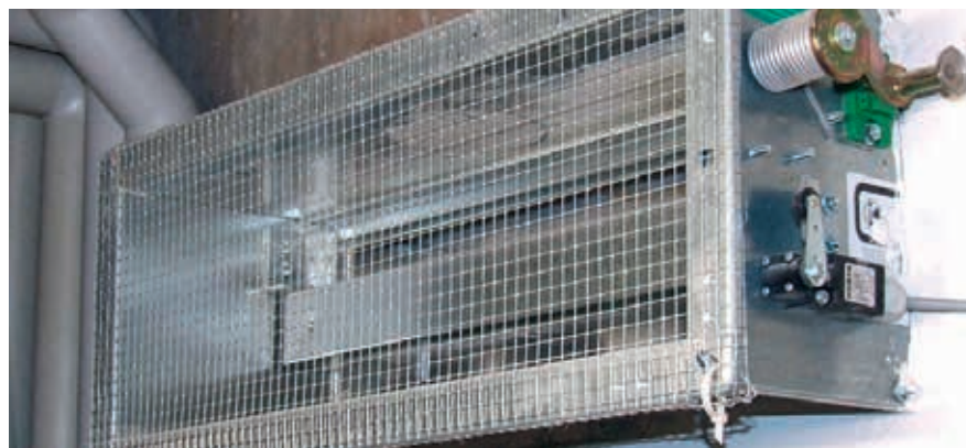
Compuerta cortafuegos
