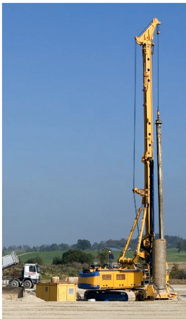
Máquinas hincapiotes y perforadoras
