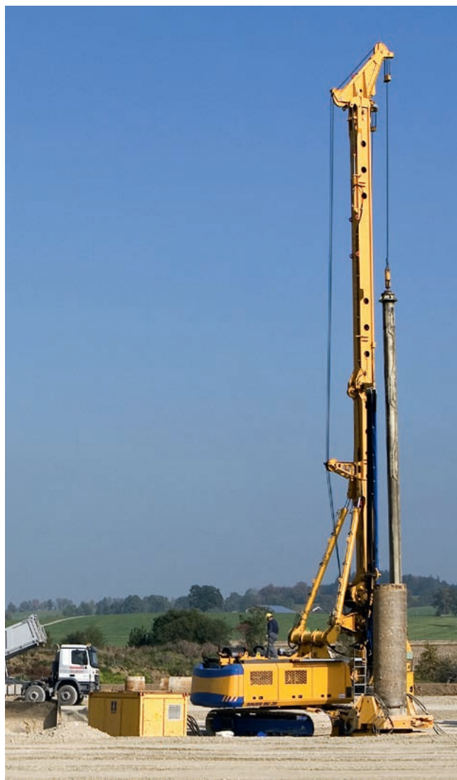
Máquinas hincapiotes y perforadoras
